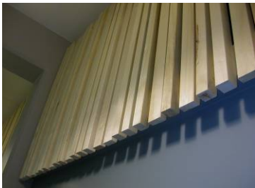
Lydpanel på Strindheim skole.
