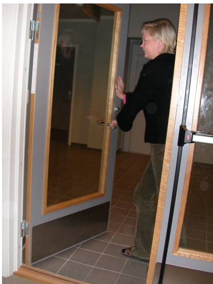
Skolen har svært mange tunge dører med terskler. I liten grad er elektriske døråpnerne montert.
