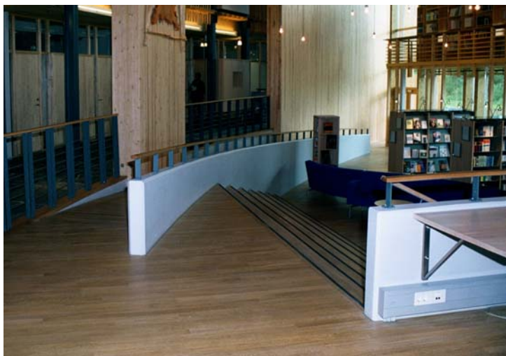
Eksempel på amfi med trinnfri adkomst og merking av trinn. (Foto fra biblioteket i sametinget i Karasjok)
