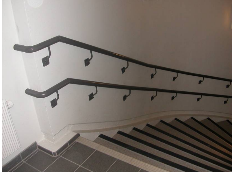
Rekkverk i to høyder
