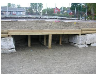
Detalj av sandkasse hvor rullestoler kan komme inntil.
