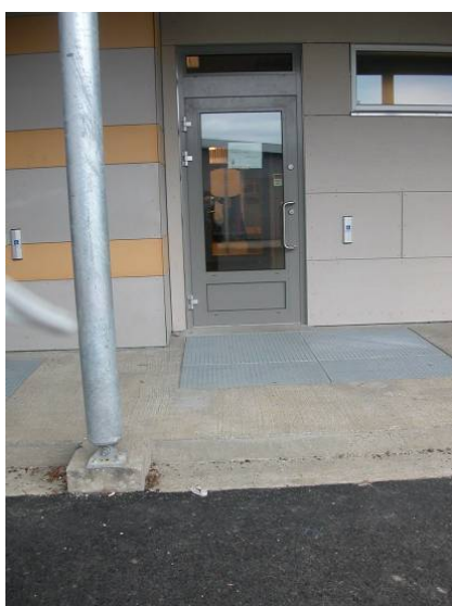
Adkomst til Regnbuen går via helsestasjon i enden av skolebygningen
