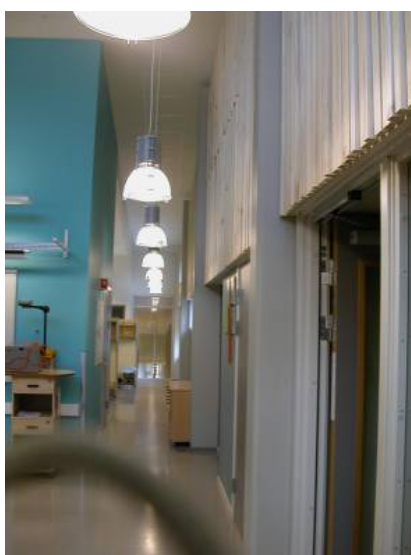
Akustisk panel i ny del. (Stående spaltepanel.)
