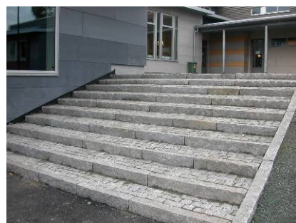
Yttertrapp uten kontrast på trappetrinn. Her mangler rekkverk på begge sider av trapp.
