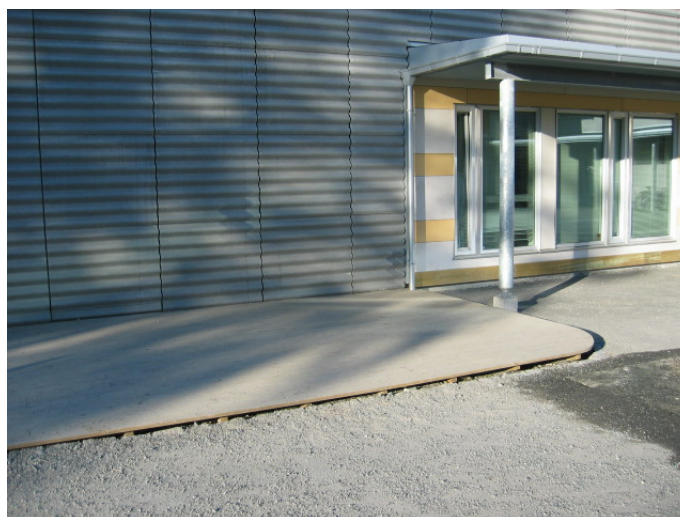
Høydeforskjellen mellom asfalten og treplatten er så stor at det er vanskelig for rullestoler å komme over. (Strindheim.)
