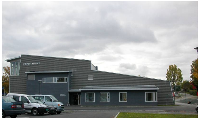
Strindheim skoles nordfasade med inngang til helsestasjonen etter ombyggingen
