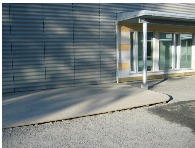
Høydeforskjellen mellom asfalten og treplatten er så stor at det er vanskelig for rullestoler å komme over. Fargeforskjell i søyle mot vegg ville gjort orienteringen enklere.
