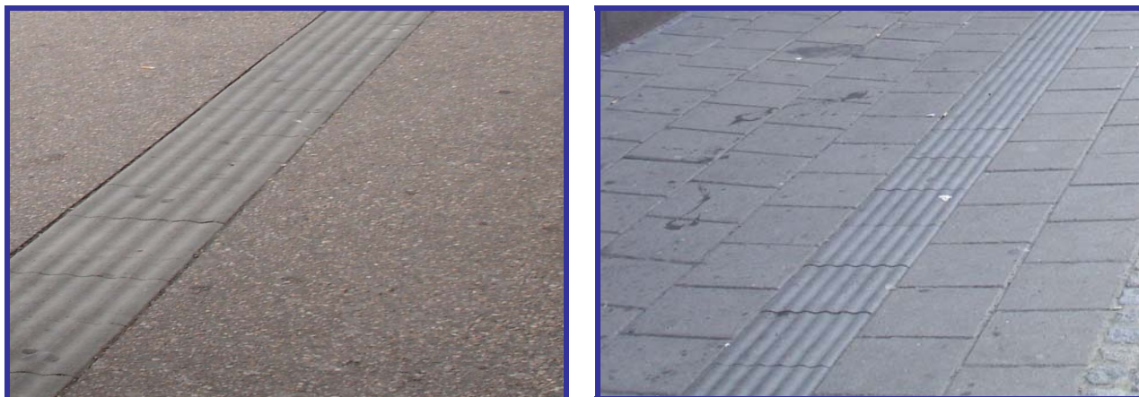
Figur 15: Asfalt og betongheller langs retningsindikatoren, strekning B
