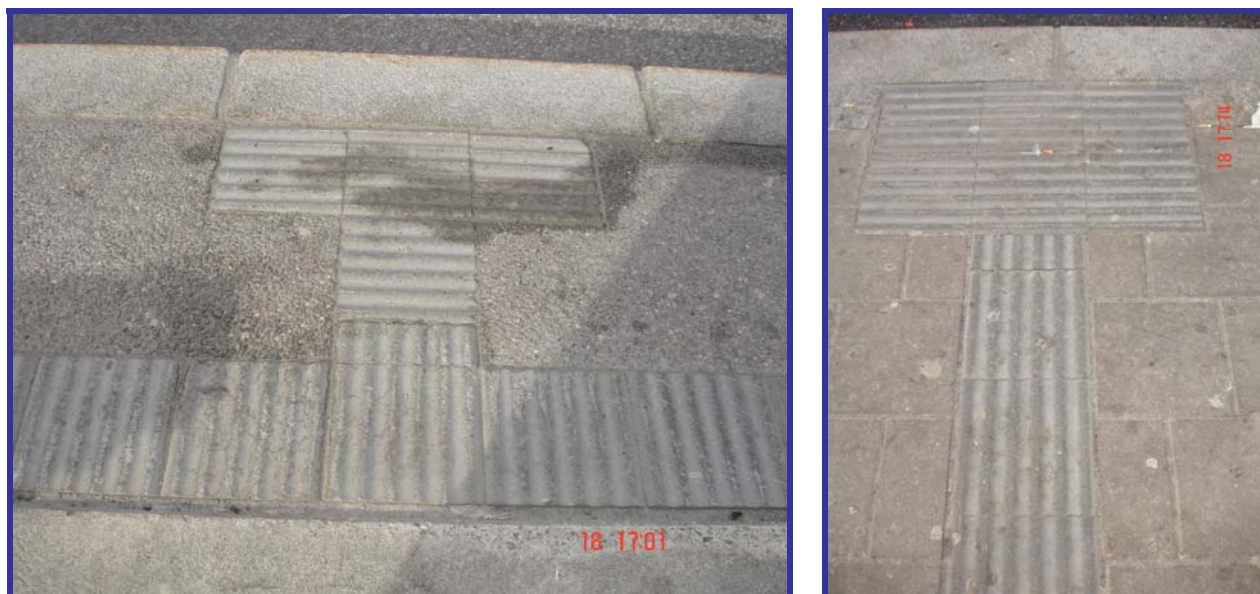
Figur 24: Oppmerksomhetsindikator på busstopp med dybde henholdsvis 30 cm og 60 cm
