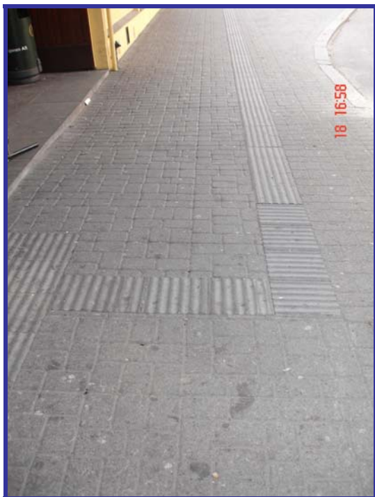
Figur 22: Oppmerksomhetsindikator ved retningsendring på 90°
