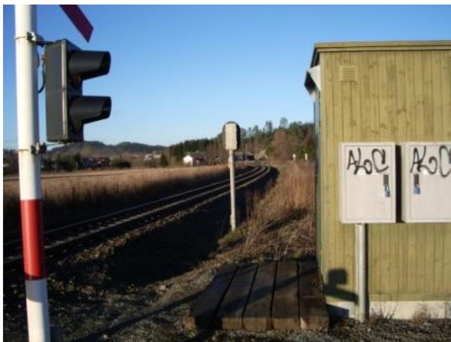
Figur 23 Jernbaneverkets eget objekt hindrer sikt
