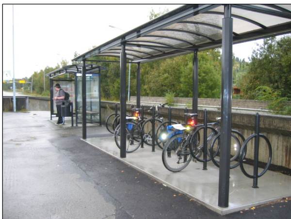
Figur 1: Eksempel på sykkelparkering ved bussholdeplass i Trondheim. Anlegget er utstyrt med låsebøyler og overbygd tak og har kapasitet til 10 sykler. Tilbudet er gratis. (Kilde: Lervåg, 2004.)
