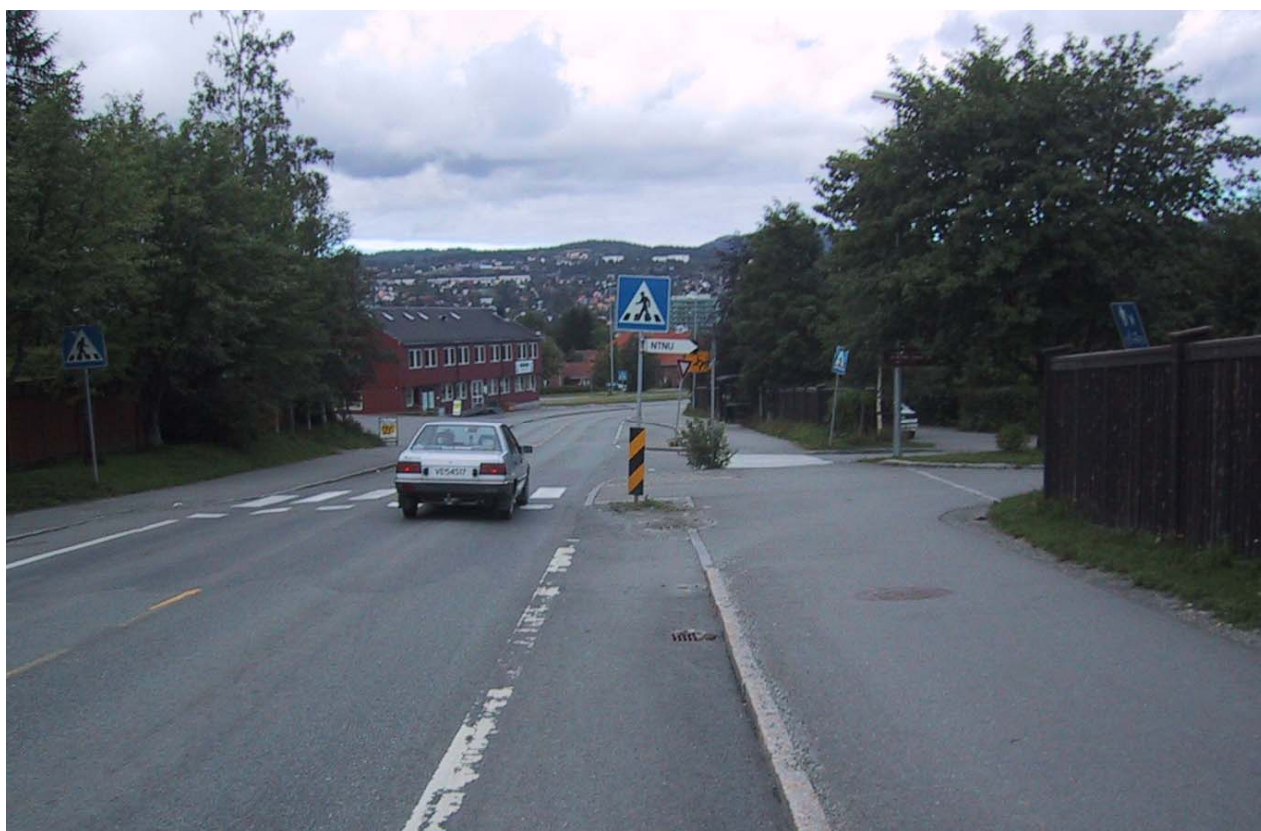
Figur 6: Eksempel på systemskifte. Sykkelfeltet stopper i et gangfelt-skilt. Planleggeren har trolig hatt en idé om at syklister skal svinge inn til høyre der det er skiltet G/S-veg. Her må syklister som skal rett frem enten sykle opp på fortauet eller skifte kjørefelt.
