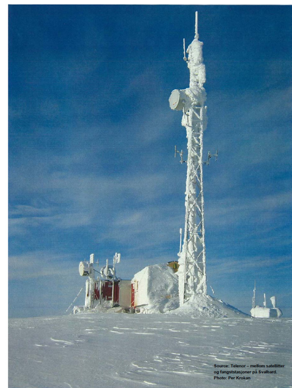
Illustrasjon av ising på kommunikasjons- installasjoner på Svalbard. Foto fra Telenor. Se bildetekst.
