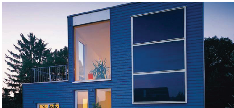
Schüco's solfangere montert vertikalt på en yttervegg.
