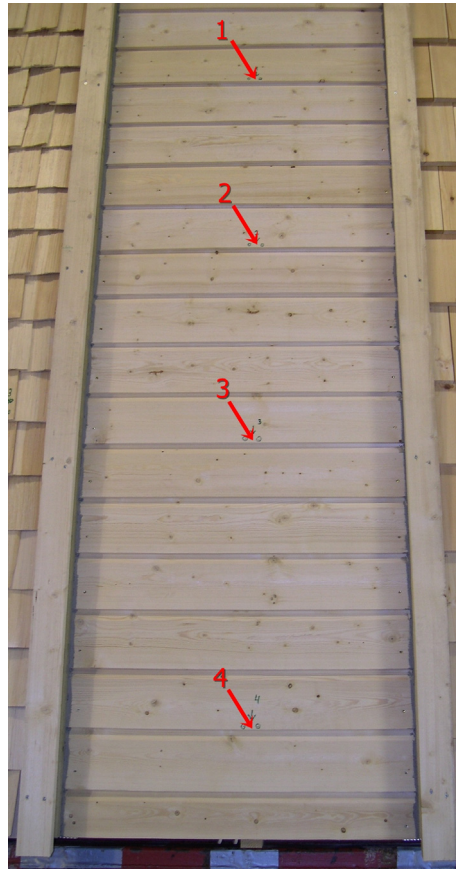
Figur 3.16 Målepunkter for trefuktighet i feltet med liggende dobbelfalset kledning
