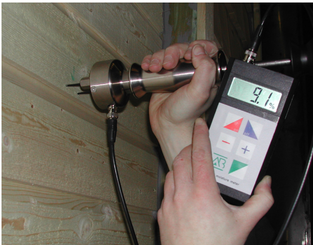
Figur 3.20 Måling av trefuktighet ved mobile elektroder i dobbelfalset kledning
