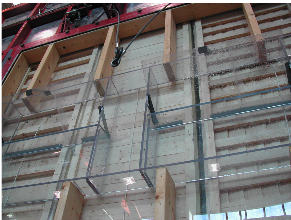
Figur 3.8 Deler av "vindspærresjiktet" er demontert ved at to leksanplater er tatt ut.
