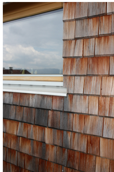
Figur 1.2 Enebolig med kledning av kløyvd spon oppført i Østerrike. Kledningen er i tidligfasen av gråningsprosessen. Arkitekt: Walter Unterrainer.
