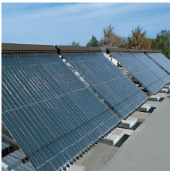
FIGUR 4-3 Solfangerpanel av typen vakuumrør.
