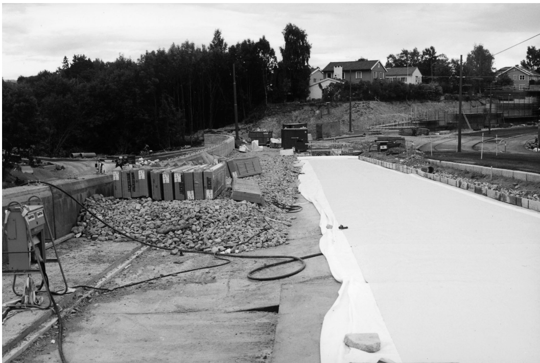
Figur 4. Trikk- og vegtrasé over Gaustadbekkdalen i Oslo der resirkulert tilslag er brukt i overbygningen (veg, trikk og gang-/sykkelveg).
