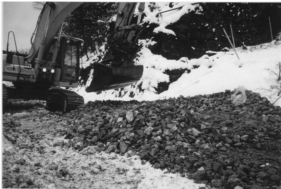
Figur 6. Utlekking av resirkulert tilslag 38-120 mm (blandet masse) som forsterkningslag på G/S-veg E18 Skøyen
