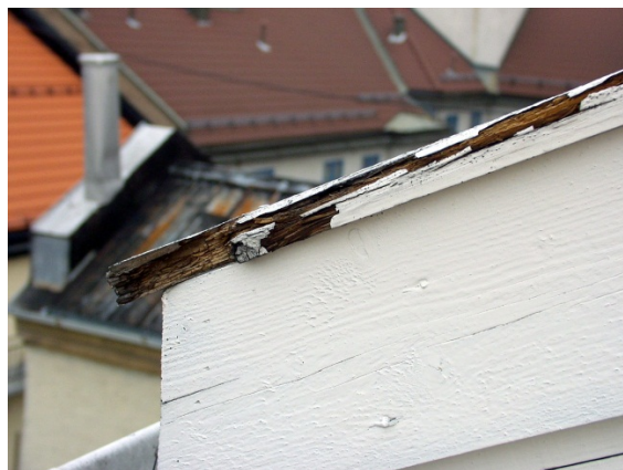
Figur 2.4.2. Vannbord har kort levetid hvis det ikke er montert beslag. (Foto: Mycoteam as)
