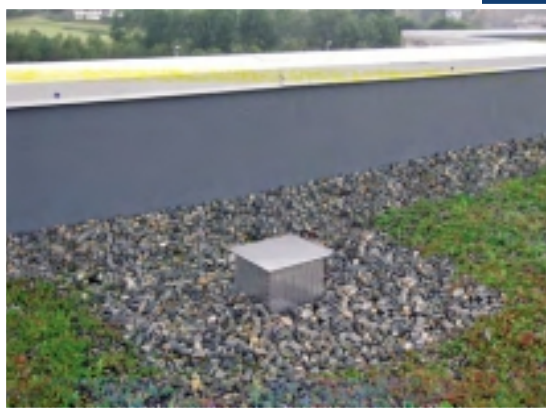
Fig. 3. Eksempel på inspeksjonskum for sluk i sedumtak. Brennbare materialer rundt sluk, nedløpsrør og parapet er utskiftet med ubrennbare materialer. Foto: SINTEF Byggforsk
