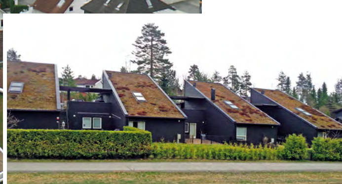
Fig. 1b. Eksempel på skrått, luftet sedumtak. Foto: SINTEF Byggforsk
