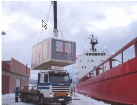
Figur 4.2.4 En modul fra Husfabrikken heises om bord i en båt. Til høyre fabrikkanlegget i Steinkjer. (Kilde: Husfabrikken Steinkjer)
