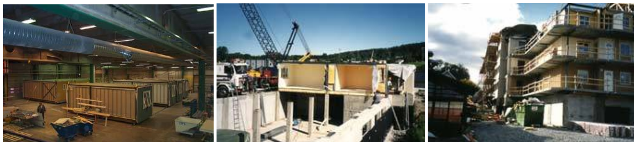
Figur 6.3.2 Tre bilder fra produksjon, montering og komplettering av en boligblokk produsert med Flexihus sine moduler
