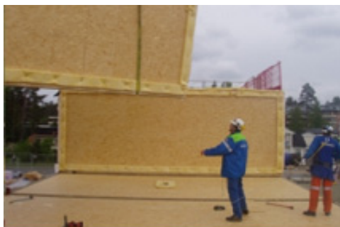
Figur 4.2.2. To bilder som viser moduler i produksjonen og under montasje (Kilde: Husfabrikken Steinkjer)
