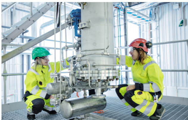
Gassifiseringsreaktoren i forbrenningslaboriet i SINTEF Energy Lab.
