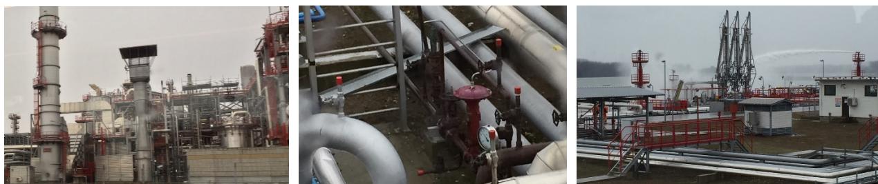
Figur 4.1 Bilder fra i) deler av hovedanlegget, ii) kritisk ventil, iii) testing av vannkanoner ved havneanlegget (Foto: Knut Øien, februar 2018)
