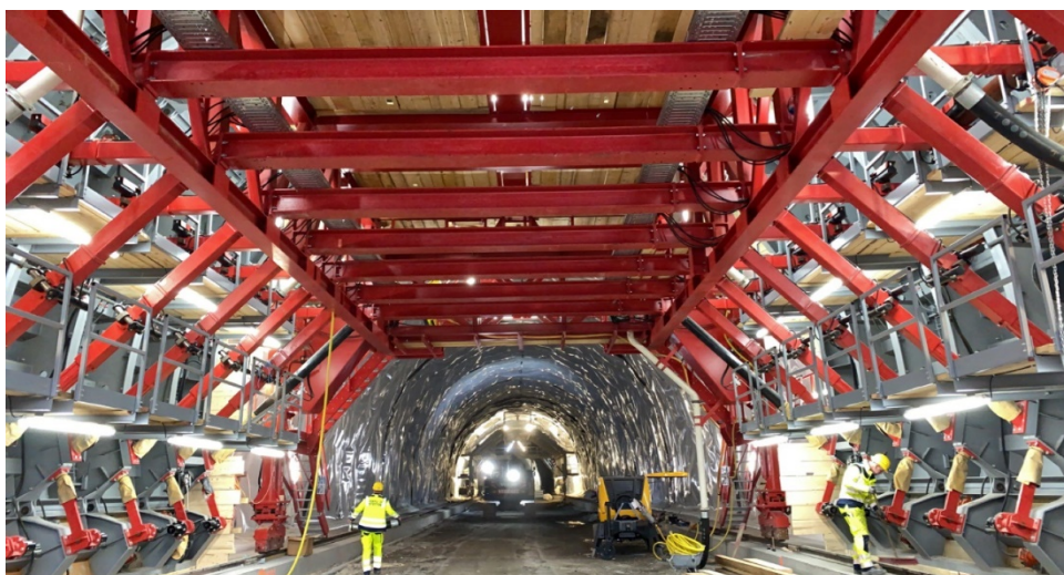
Figur 8-1: Tunnelvogn som ble brukt på UDK01, som på det meste ble brukt på 6 støper i uken. (Foto: Andreas Sjaastad)
