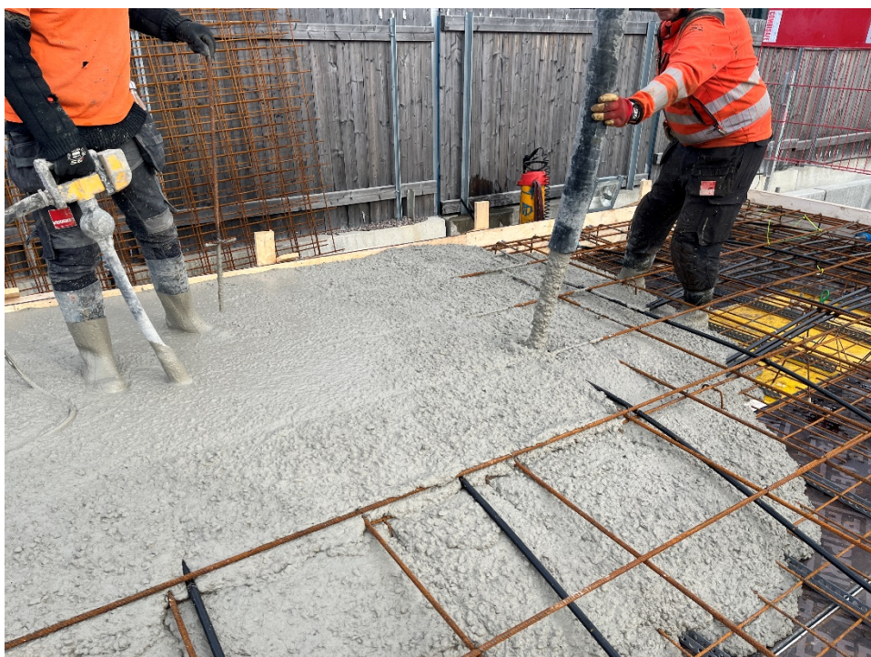
Figur 14-6: Prøvestøp av dekke over søyler og vegger, som skulle spennes opp når betongen hadde oppnådd 25 MPa. (Foto: Andreas Sjaastad)
