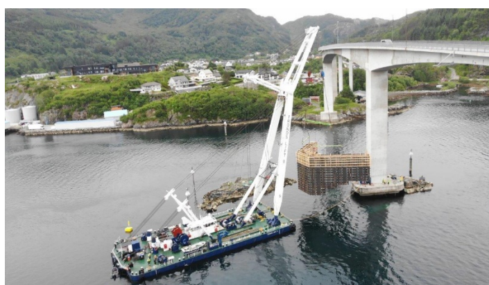
Figur 17-4: Bilde fra modell, den prefabrikerte rammen med forskaling og armering er 40 meter bred, opptil 10 meter høy, er over 1 meter tykk, og veier over 100 tonn.
