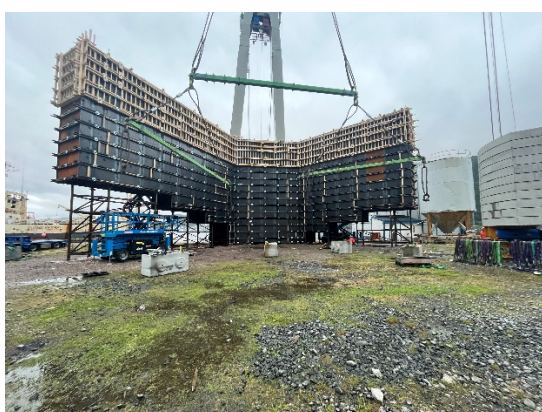
Figur 17-4: Bilde fra modell, den prefabrikerte rammen med forskaling og armering er 40 meter bred, opptil 10 meter høy, er over 1 meter tykk, og veier over 100 tonn.
