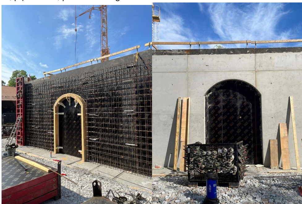
Figur 13-1: Betongarbeider med ekstrem lavkarbonbetong med resirkulert betong, som trengte ekstra planlegging, tiltak og oppfølging.
