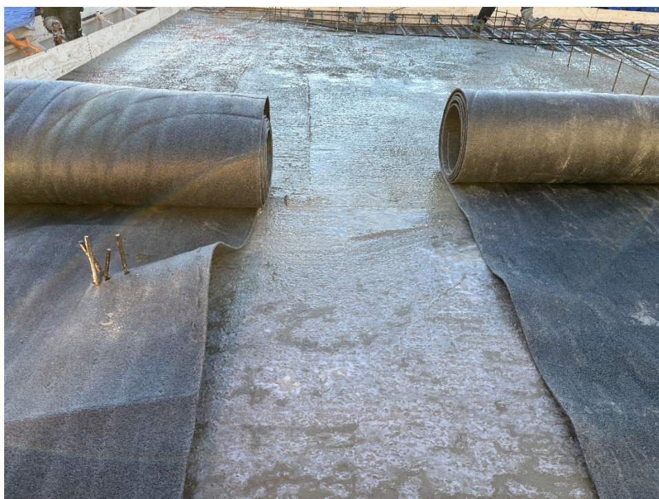
Figur 14-4: En akselerator ble testet som overflateherder, for å kunne legge på isolasjon tidligere. Absolutt noe som kan benyttes, men begrensning i størrelse og kompleksitet på dekket. (Foto: Andreas Sjaastad)
