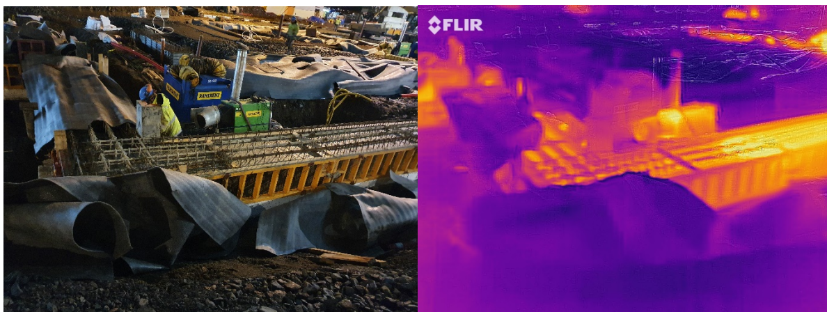
Figur 6-2: Vanlig bilde og termografering av betongstøp med innstøpte varmerør. Bilde: Nils Ivar Nilsen
