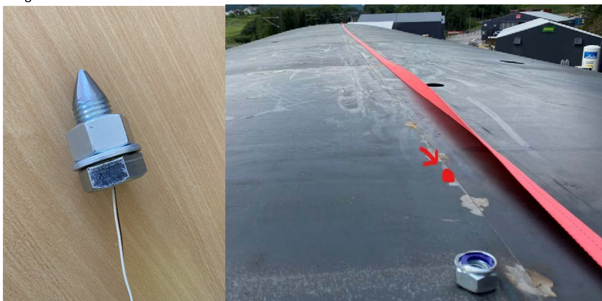
Figur 8-2: Veidekke utviklet en plugg som ble montert på forskalingen og fulgte forskalingen for hvert støpeavsnitt, uten behov for kutting og oppsett av ny kabel for temperaturlogging.
