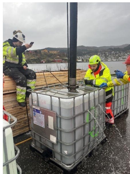
Figur 17-2: Det ble utført tester med undervannsbetong for å kontrollere at den egnet seg å støpe under vann. (Foto: Alf Egil Mathisen)
