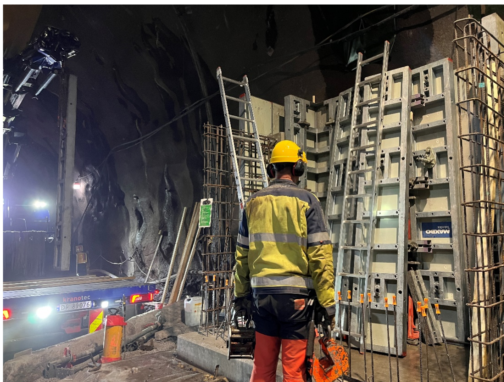
Figur 12-10: Prøvestøp av et basseng i tunnelen på Kattås for å kontrollere at beregningene og tiltakene som ble planlagt fungerer som tiltenkt.
