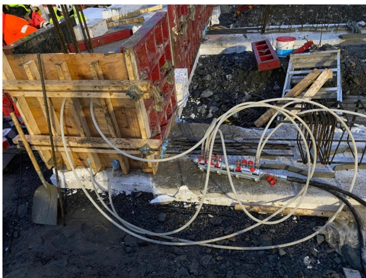
Figur 6-3: PVC-rør ble innstøpt for å øke temperaturen i betongen, slik at den fikk tilstrekkelig/rask nok fasthetsutvikling. Bilde: Andreas Sjaastad
