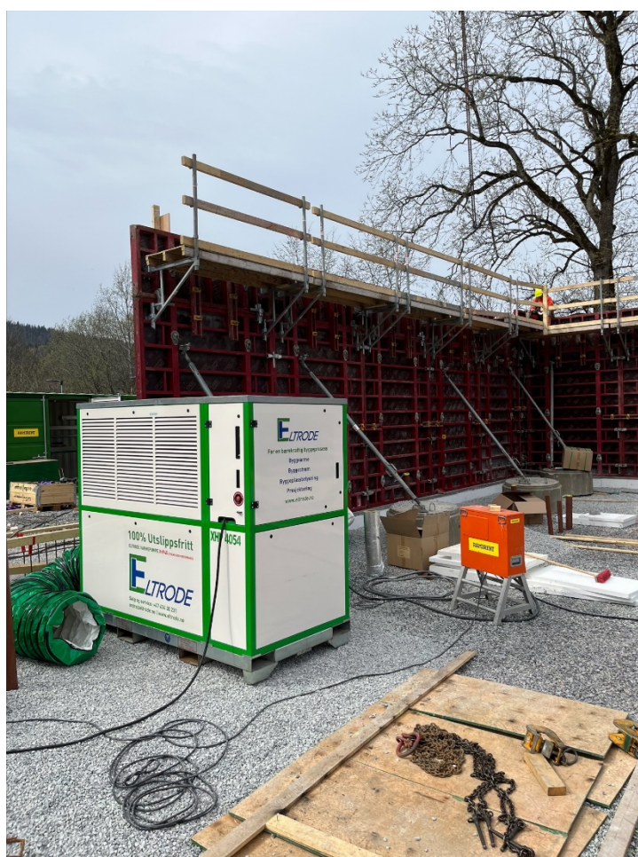
Figur 13-3: Et av tiltakene var ekstra oppvarming av betongen og flatene som betongen kom i kontakt med, og dette måtte gjøres med strømaggregat grunnet høye miljøkrav.
