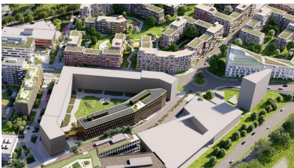
Figur 14-1: Oversiktsbilde av Veidekkes nye hovedkontor på Ulven, der det ble utført ulike tester for å benytte seg av ekstrem lavkarbonbetong med resirkulert betong som tilslag. (Foto: Veidekke)
