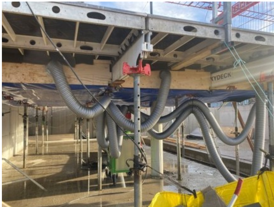
Figur 14-9: Et av tiltakene var oppvarming med varmluft, men området ble begrenset til rett under dekket, slik at man ikke varmet opp unødig område/luft. (Foto: Alf Egil Mathisen)
