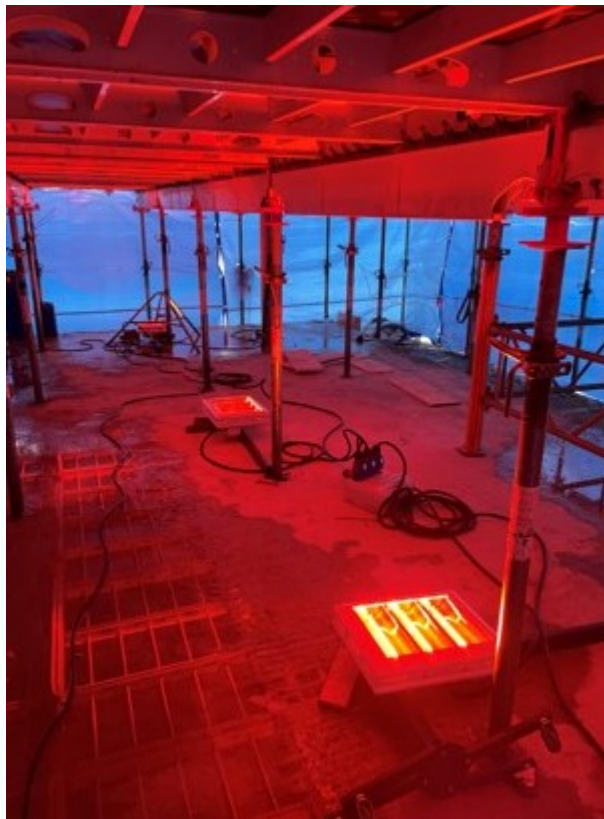
Figur 14-7: Et av tiltakene som ble testet var lamper med infra rød stråling (IR) og hadde overaskende god effekt. (Foto: Alf Egil Mathisen)
