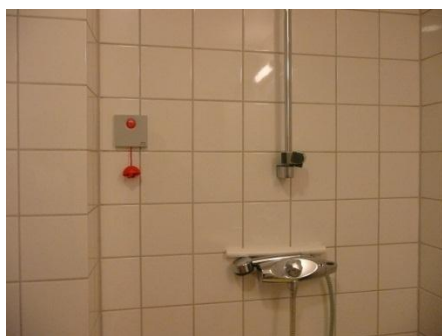
Figur 10 Snoralarm på bad mangler snor
