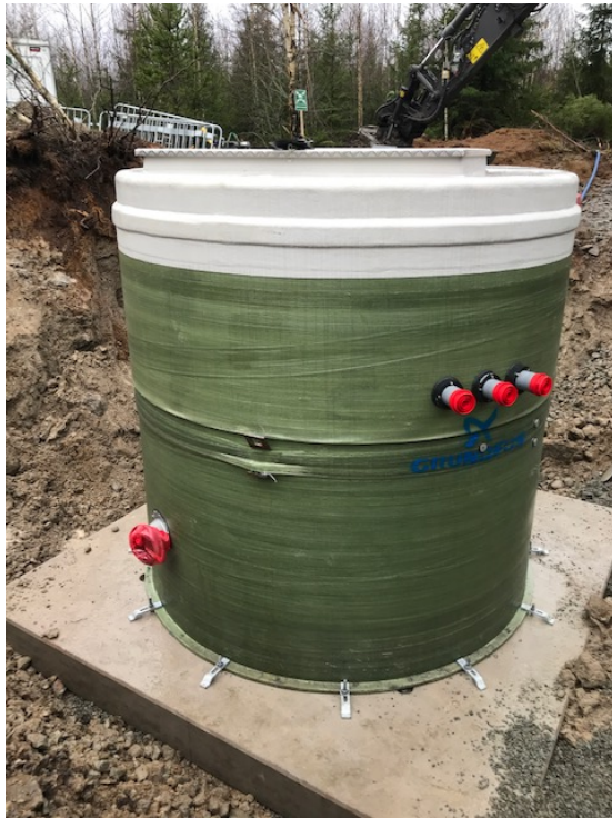
Förankring i bottenplatta
