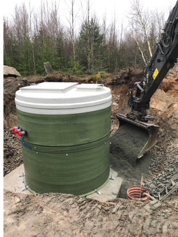
Återfyllning påbörjas
