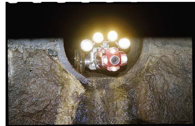
TV inspeksjon (NorskVan)
