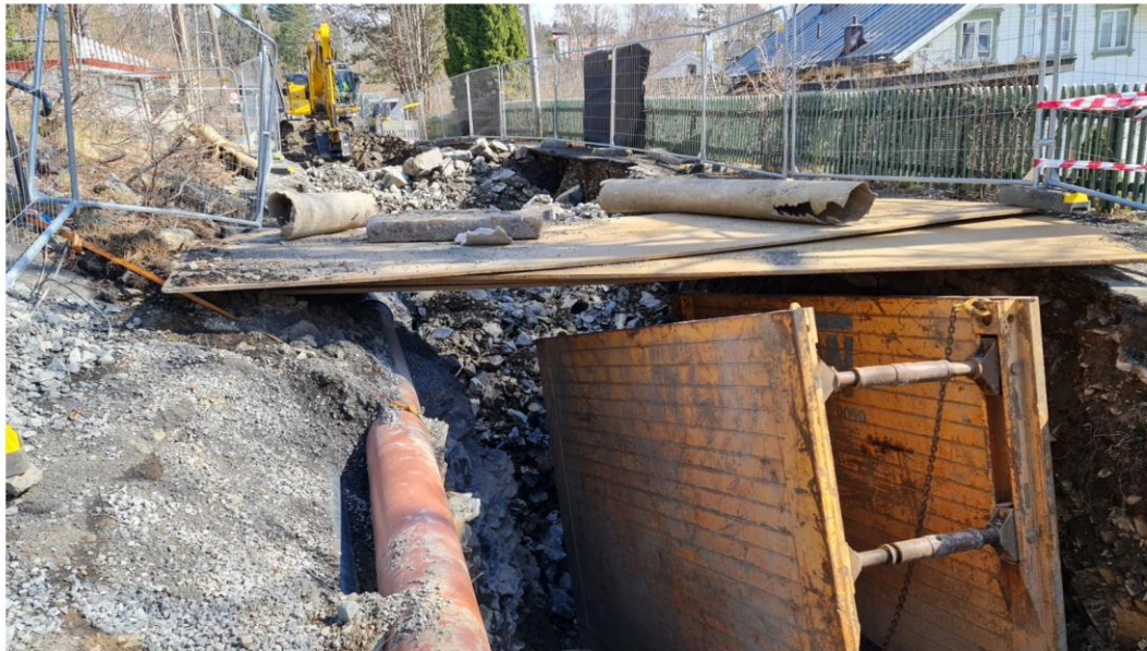
I byene koster det 10.000–15.000 kroner per meter ledningsgrøft. Cowi skal undersøke mulighetene for å benytte gravefrie løsninger mer. (Illustrasjonsfoto: Knut Bjørheim)
