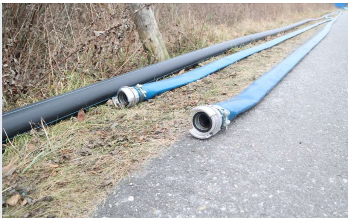
Det jobbes på spreng med å reparere hovedvannledningen langs Tyvikveien.
