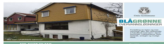
Bilde 1: Frakobling av taknedløp fører vannet ut på planen og reduserer muligheten for oversvømmelse av kjeller.
