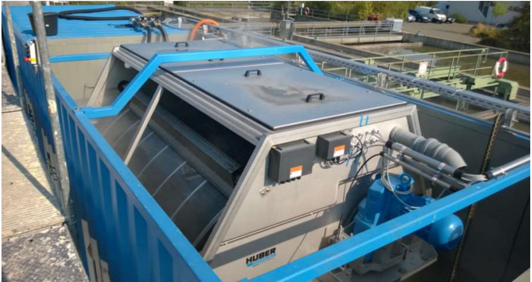
Utloppssektion på trumsil LIQUID Mesh 2200/0,3.
