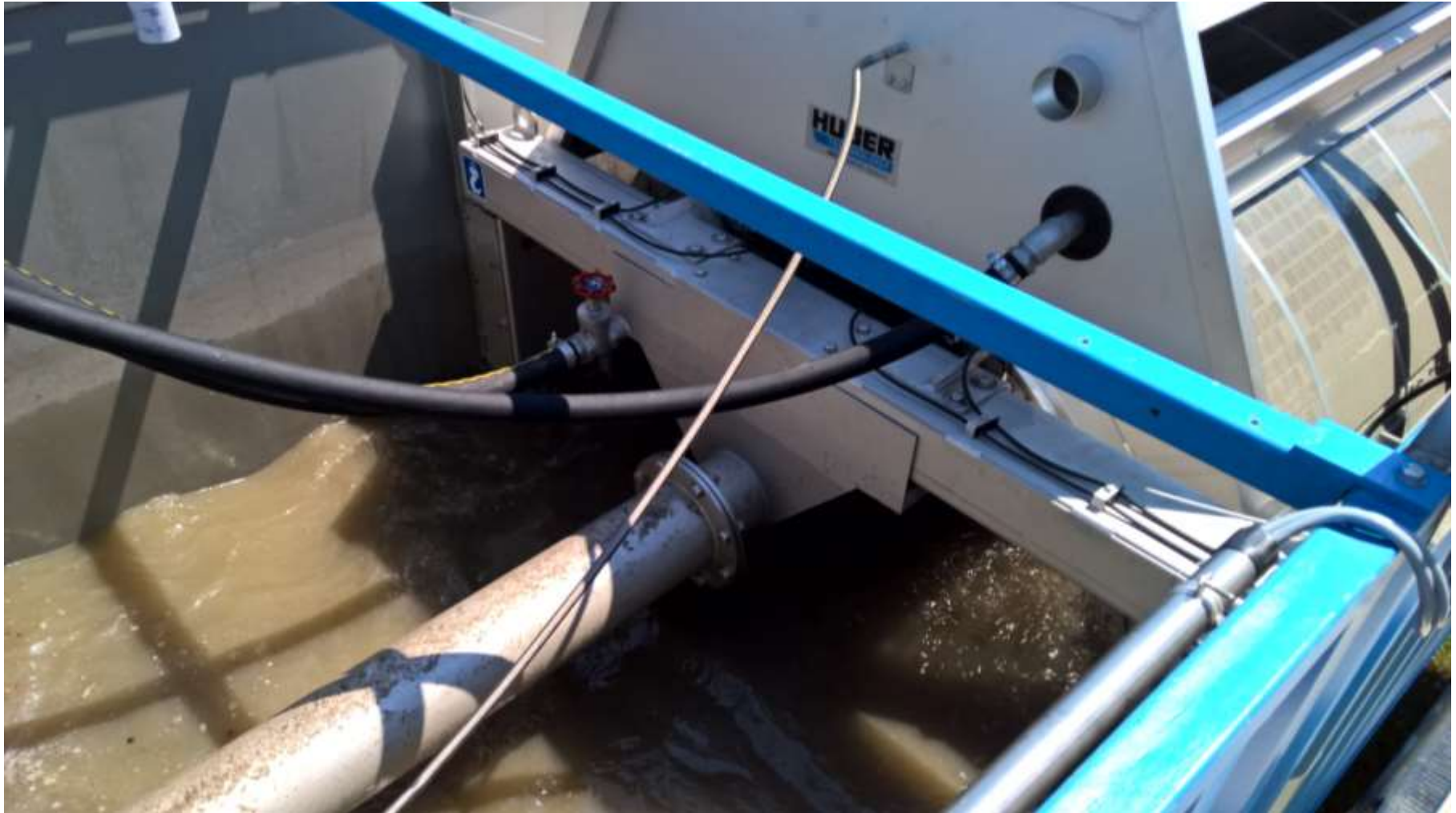
Innløet på trumsil LIQUID Mesh 2200/0,3.
