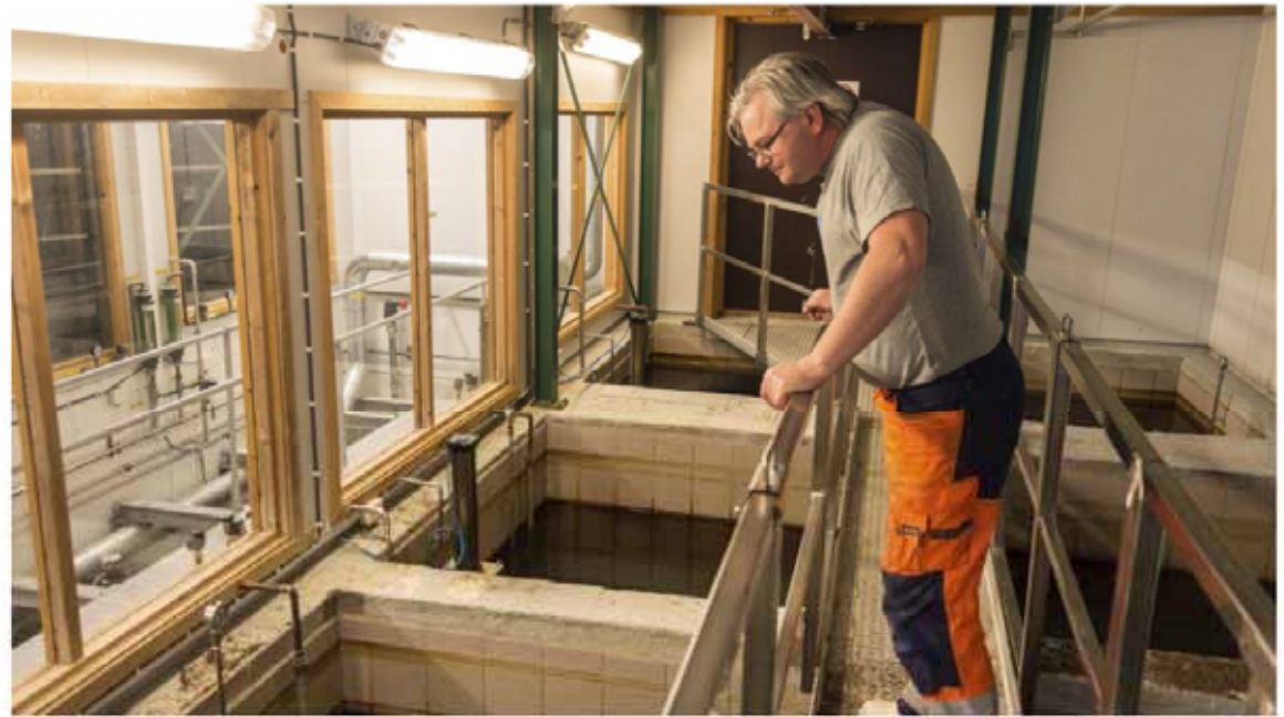
FILTER: I disse kummene, i alt 20 stykker, fylt med sand, filtreres vannet for partikler. Terje Fagernes sler anlegget har dobbelt så stor kapasitet som dagens vannproduksjon på 4,5 millioner liter per døgn. Foto: Øivind Rånes
