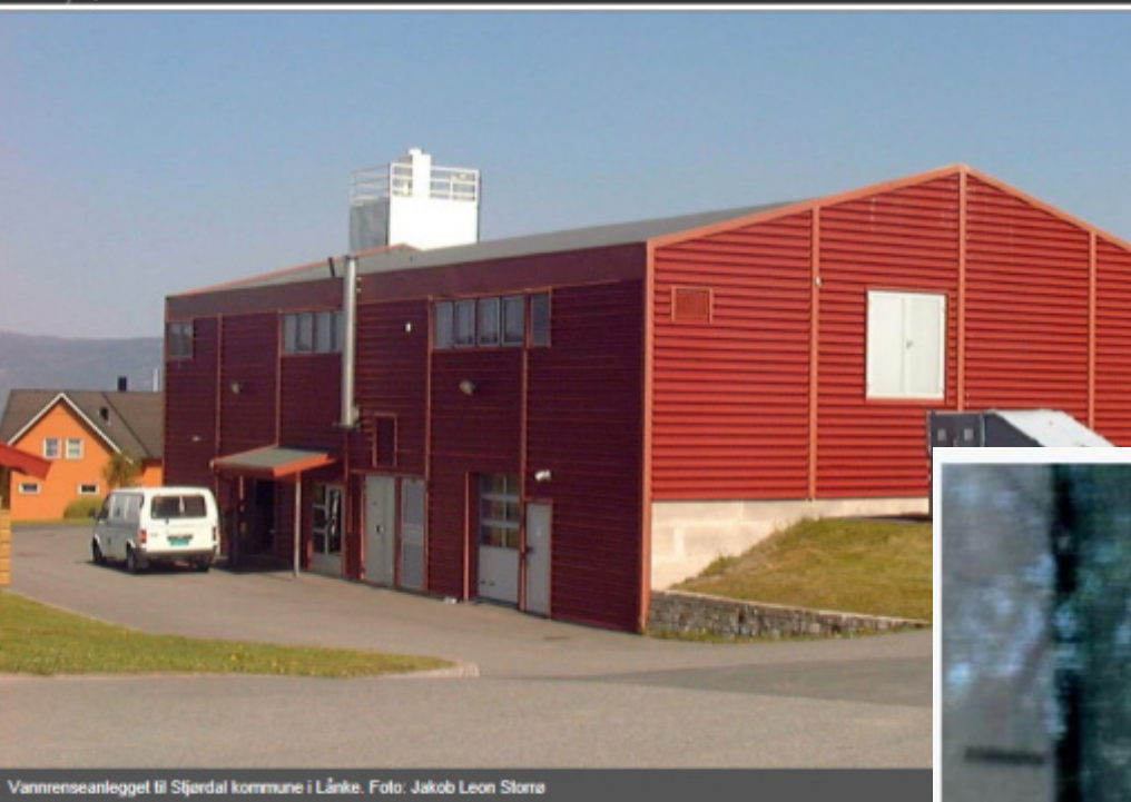
Vannrenseanlegget til Stjørdal kommune i Lånke. Foto: Jakob Leon Storm
