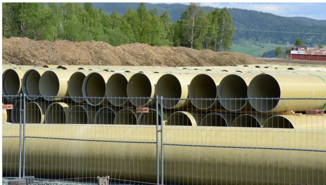
Det er stor dimensjon på vannrørene som legges.
