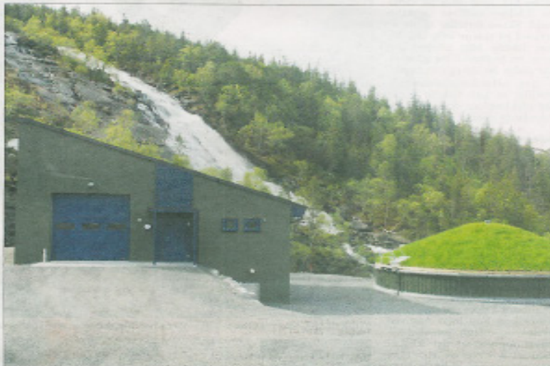
STORDALEN VASSVERK med høydebasseng og renseanlegg. Av en eller annen merkelig grunn har rensedvann herfra uspettlig lukt og smak.
