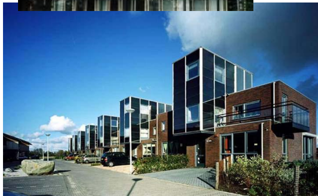
Solceller i fasadene i rekkehusprosjekt. Nederland. Kilde: Kiss&Cathcart Gregory Kiss
