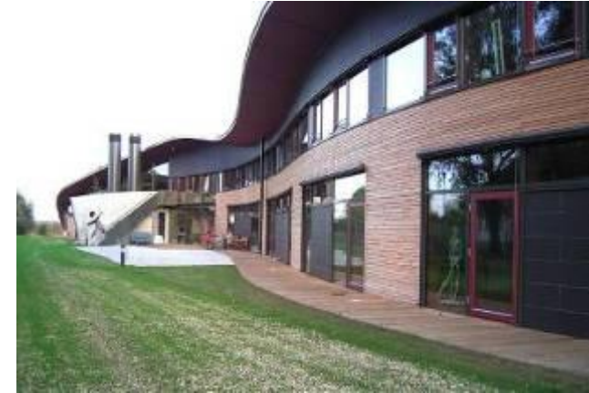
Passivhusskole i Aufkirchen, Tyskland.. Kilde: www.passivhausprojekte.de
