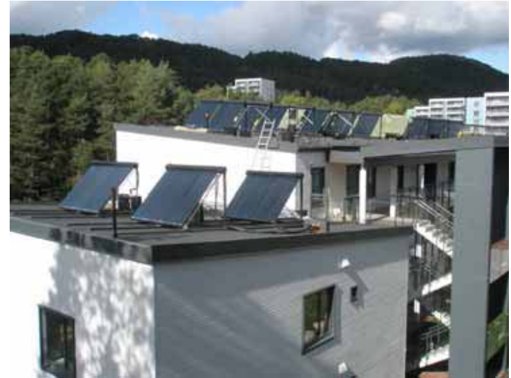
Solfangeranlegg (vakuum), Løvåshagen, Bergen
