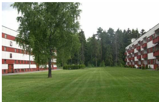
Før: Totalt 168 leil. skal oppgraderes
