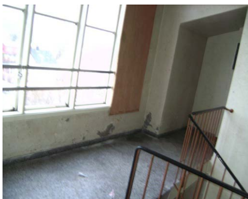
Før oppgradering, Trappeoppgang, Dalegata 52
