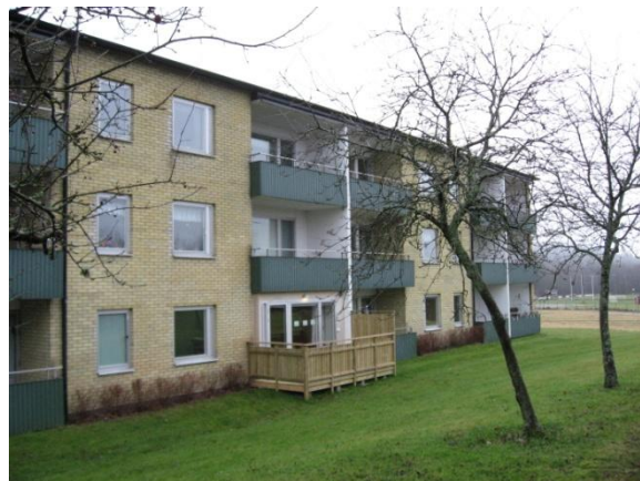
En leilighet (nederst, midt på bildet) er rehabilitert. Nye frittstående balkonger skal erstatte de gamle for å unngå kuldebroer og for å utvide stuearealet.
