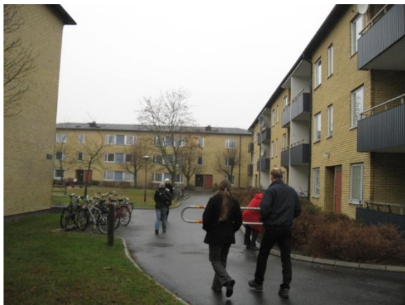
Før: Totalt 300 leiligheter skal rehabiliteres. Først fornyes en bygning med 18 leiligheter. Erfaringer overføres til resten av området.
