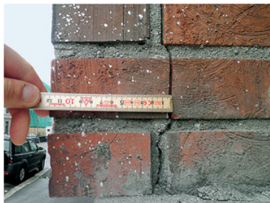
Ettersyn av murt fasade i teglstein avdekker vertikal sprekk i hjørne på grunn av manglende bevegelsesfuge og for lite opplegg for teglvangen. Foto: Norconsult AS
