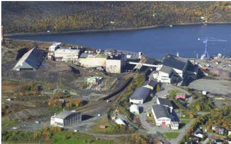
Kirkenes med prosessanlegget til Sydvaranger gruve AS.
