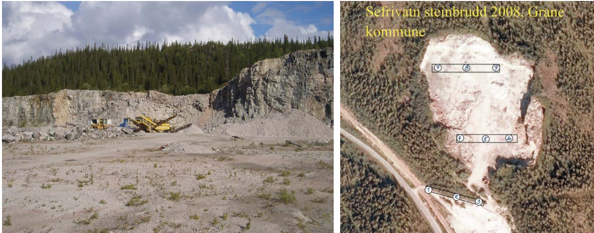
Figur 5: Sefrivatn pukkverk i Grane kommune. Etablert av Norges Statsbaner for å levere pukk til byggingen av Nordlandsbanen. Bilde til høyre viser vertikalfoto av steinbruddet med plan for uttak av steinprøver for nye analyser av mekanisk styrke. Prøve 1 til 3 nede ved riksveien representerer terrengprøver (dagfjellsonen) og prøve 4 til 9 tas i sålen av bruddet som antas å ligge under dagfjellsonen.
