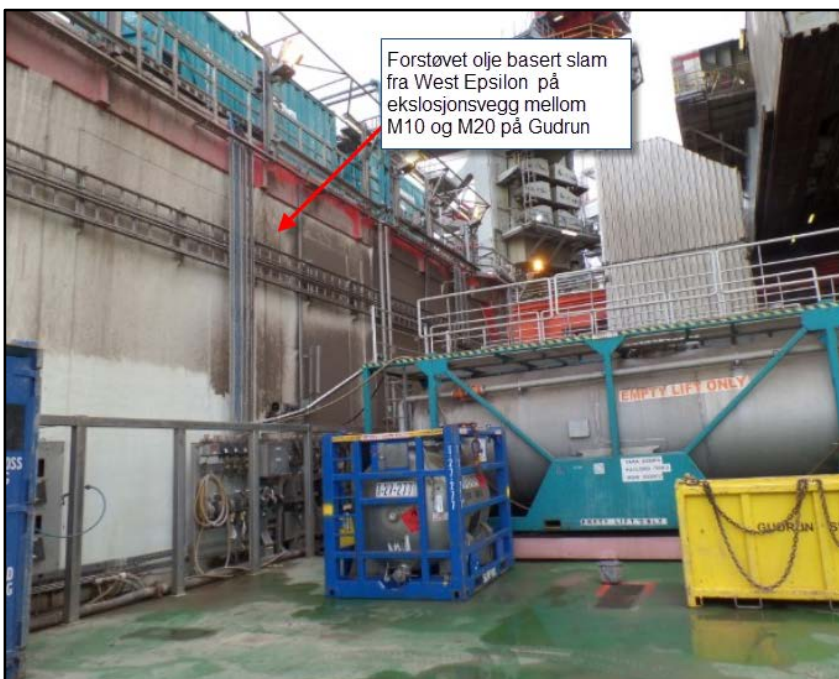
Figur 6-2 Forstøvet oljebasert mud gikk over vindvegg mot Gudrun
