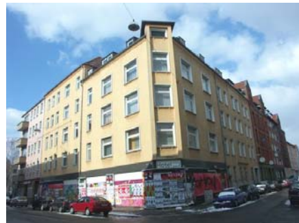
Bild: Före renovering © Dr. Ulrich Stiebel
