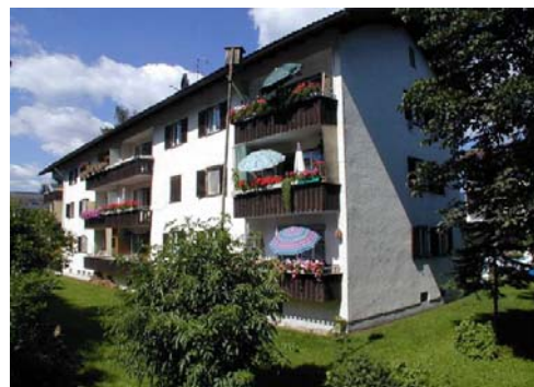
Bild: Gesamtansicht, © SWW Oberallgäu
