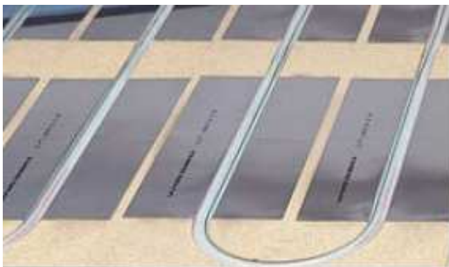
Figur 1: Konvensjonell vannbåren gulvvarme i oppholdsrom, brukes i mange leilighetsprosjekter i dag.
