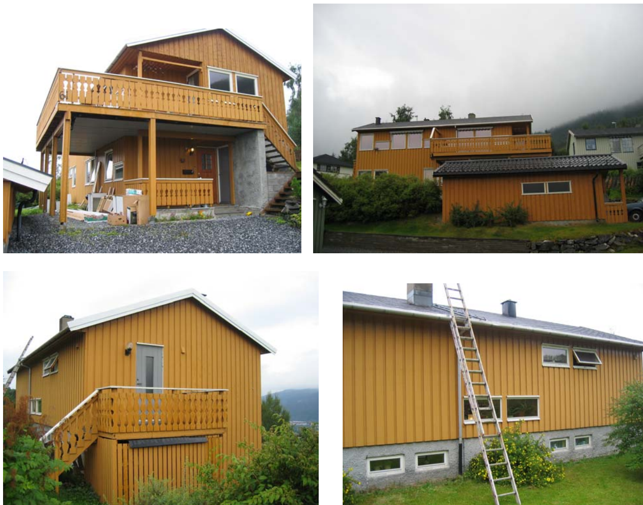
Figur 1 Øvre Hovsbakkan 61: Inngangsparti mot sør (øverst til venstre), vestfasaden (øverst til høyre), nordfasaden (nederst til venstre) og østfasaden (nederst til høyre).
