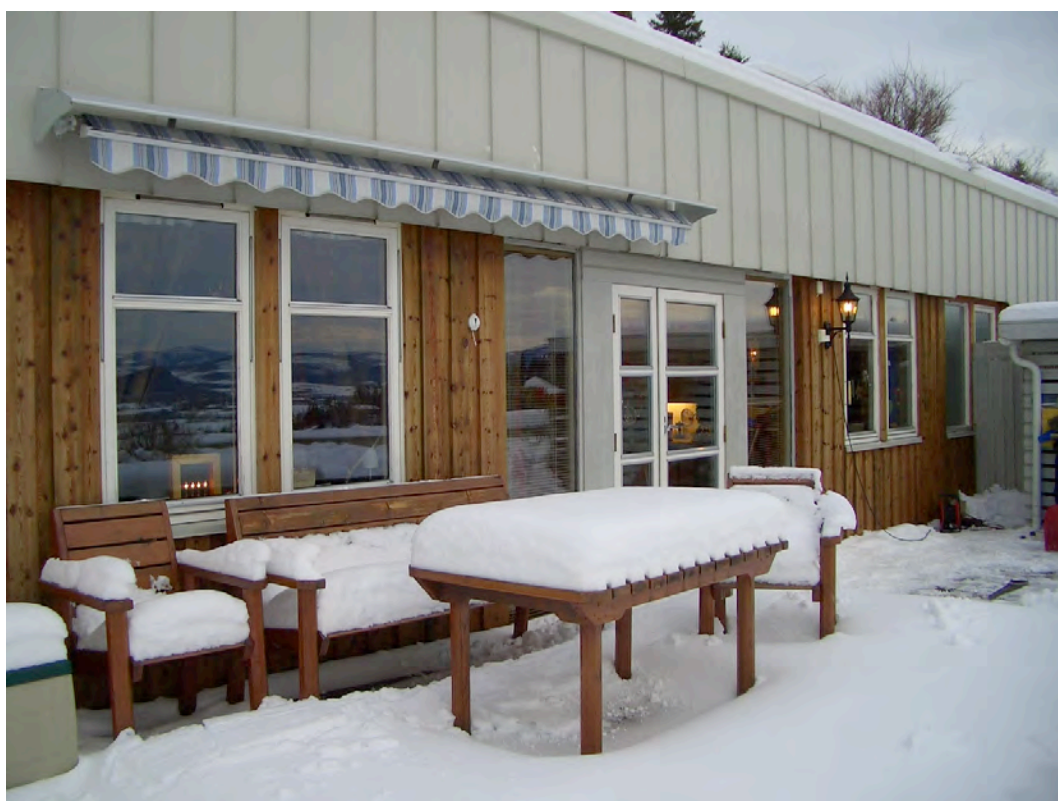
Frontvegg mot terrasse før rehabilitering
