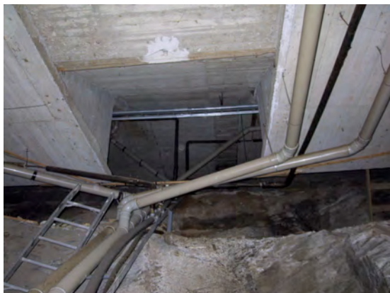
Kulvert under helle blokka, god temperatur
