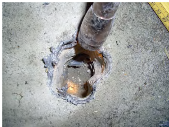
Avdekking av isolasjonssjikt under terrassedekke (dvs tak over leilighet)
