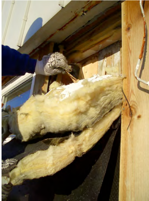
Detaljer i frontvegg før rehabilitering
