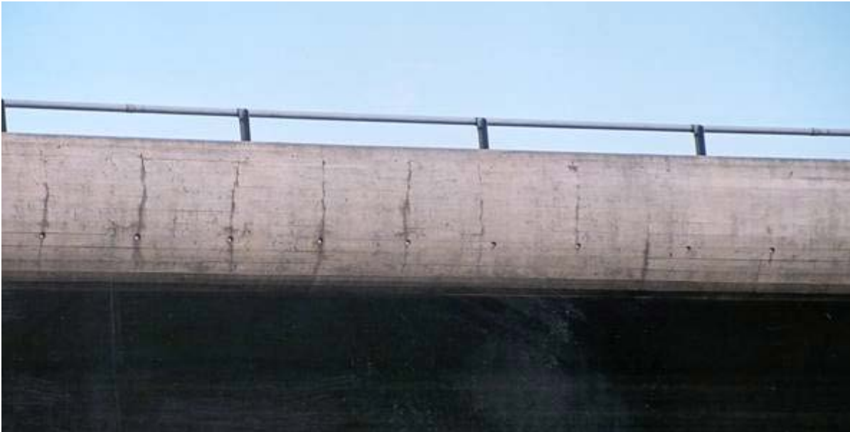
Figur 2 Eksempel på riss i kantdrager pga. fastholding fra det tidligere støpte brulegemet (foto: Steinar Helland)
