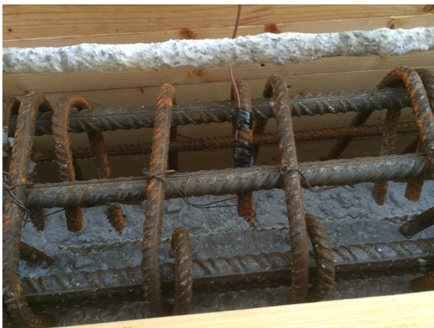
Figur 11 Plassering av termoelement i kantdrager
