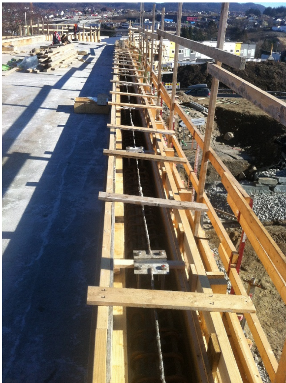
Figur 8 Kantdrager før/under utstøping med pumpe/vibrator
