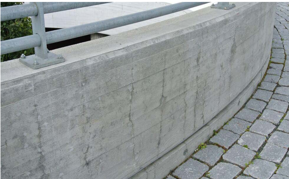
Figur 3 Eksempel på riss i kantbjelke pga. fastholding fra det tidligere støpte brulegemet [2]
