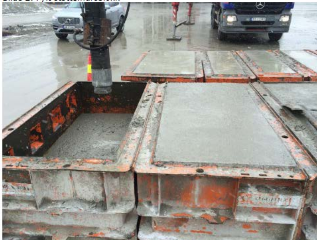
Bilde 2. Fylt støttemursblokk
