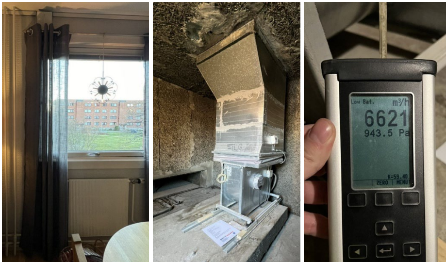
Figur 36. Kartlegging av en eldre boligblokk i COFACTOR-datasettet med gjennomsnittlig energibruk for arketyperen. Avtrekksventilasjon hvor luft trekkes inn gjennom ventiler langs fasadene og trekkes ut til felles avkastvifte er typisk for boligblokker fra 1970–80-tallet. Avtrekksmengdene kan være på moderne forskriftsnivå.
