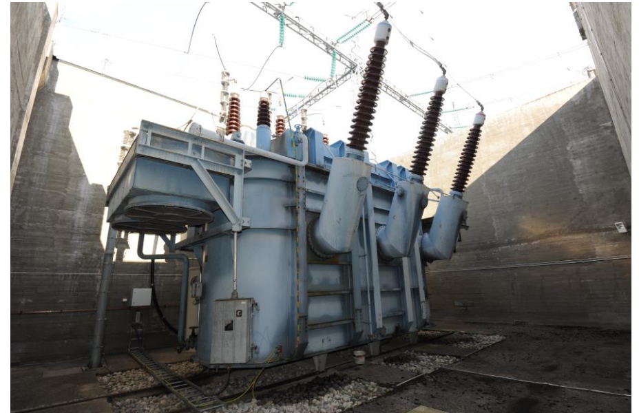
Bilete av krafttransformator frå Statnett
