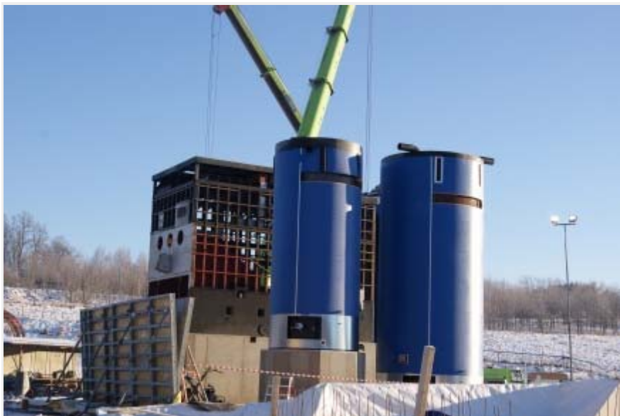
Statkraft Varme AS sitt nye fjernvarmeanlegg på Campus Ås reiser seg. Photo: Stein Valsø
