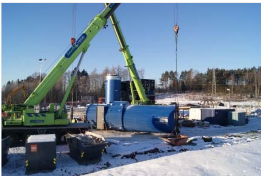
Filterenheten som skal hindre utslipp fra anlegget klar for montering. Photo: Stein Valsø
