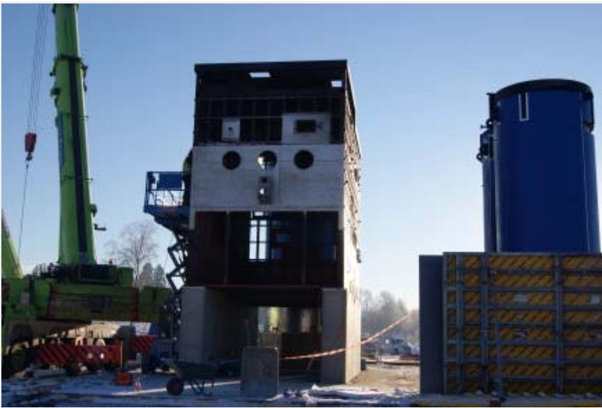
I denne kolossen skal flisovnen monteres. Photo: Stein Valsø
