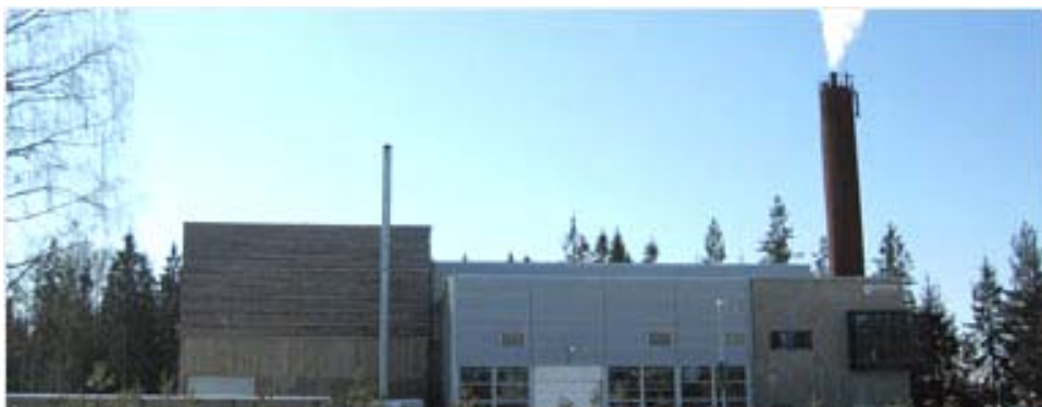
Figur 3.63 Biobrenselanlegget ved Oslo Hovedflyplass, Gardermoen (Hafslund, 2005).
