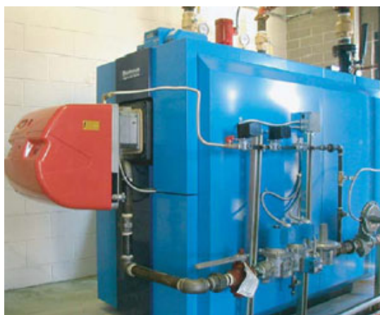
Figur 3.21 Eksempel på gasskjel/-brenner for større bygninger.
