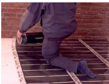
Figur 3.7 Eksempel på montering av varmemefolie i gulv.
