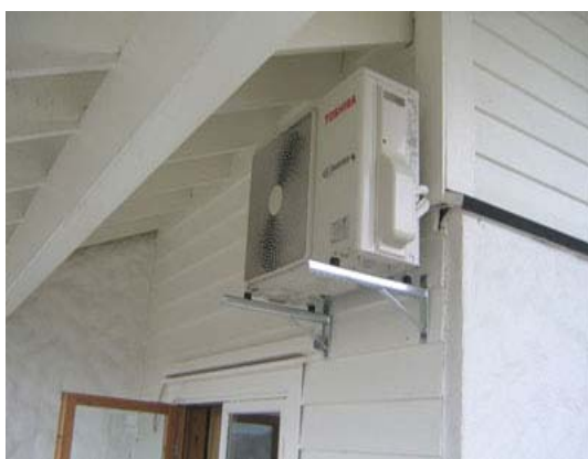
Figur 3.41 Eksempler på monteringer av ute-enheter for luft/luft-varmepumper.
