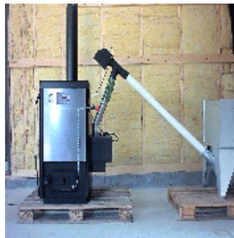
Figur 3.29 Eksempel på tilførselssystem for pellets samt en pelletsjel med pelletssilo og mateskrue.
