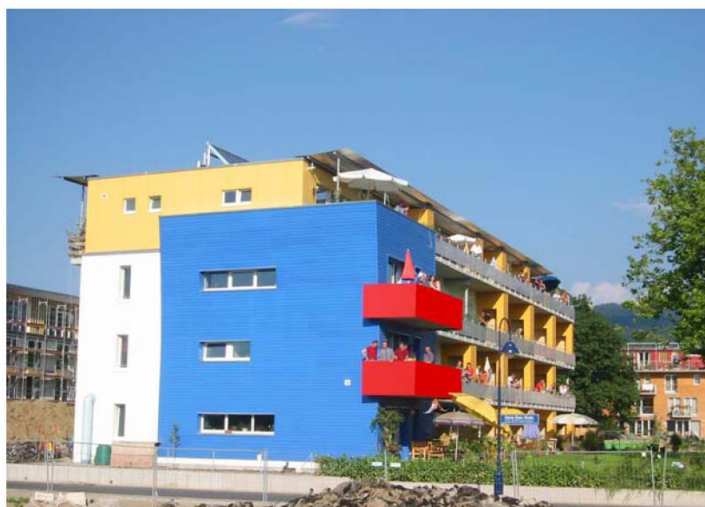
Figur 3.57 Eksempel på et passivhus (boligblokk) med integrert ventilasjons- og varmeanlegg med avtrekksluft-varmepumpe og solfangerer (Bühning, 2005).
