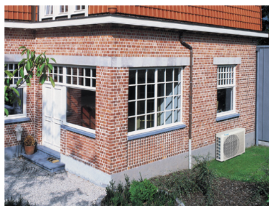
Figur 3.41 Eksempler på monteringer av ute-enheter for luft/luft-varmepumper.
