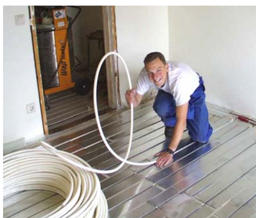
Figur 4.9 Legging av gulvvarmerør i profilerte aluminiumsplater (venstre) samt eksempel på utføring av lett gulvvarmeanlegg i mellombjelkelag (Gundersen, 1998).
