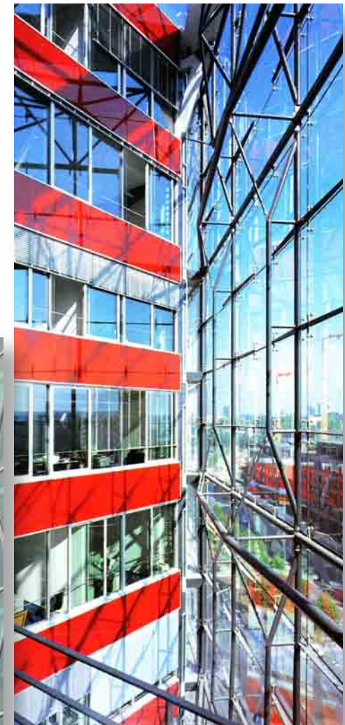
Gatermann + Schossig Architekten Bürohaus XX - Dusseldorf
