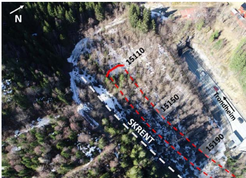
Figur 4-5. Dronebilde av anleggsområdet, med fjellskrent (hvit stiplet linje) og trasé for nytt tunnelløp (rød stiplet linje) sør for dagens E6. Prosjektet påhugg er indikert med rød heltrukken linje i vest. En tidligere anleggsvei, nå tursti, skimtes ovenfor anleggsområdet [13].
