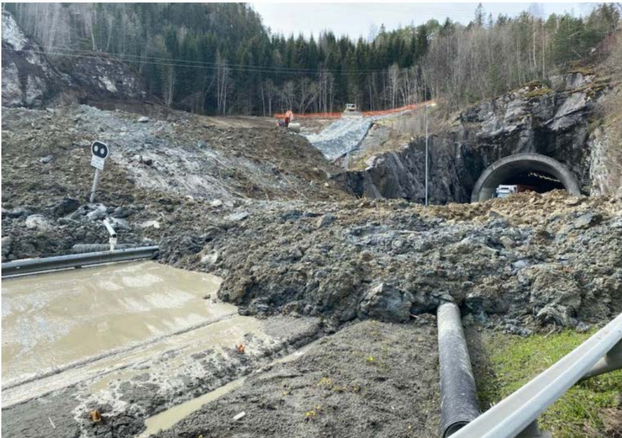
Figur 2-8. Bilde av skredet 4. mai, sett fra Hommelvik bru [10]. Skredmasser havnet over E6. Anleggsveien sør for E6 observeres under skredmassene.
