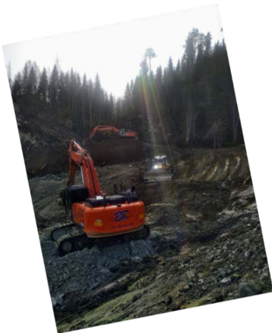
Figur 2-7. Bilder tatt på formiddagen 4. mai (foto: Br. Bjerkli AS). Underentreprenør gravde ned toppen av skråningen og en bulldoser flyttet massene bortover mot annen gravemaskin, som lastet på dumpere for transport ut av området.
