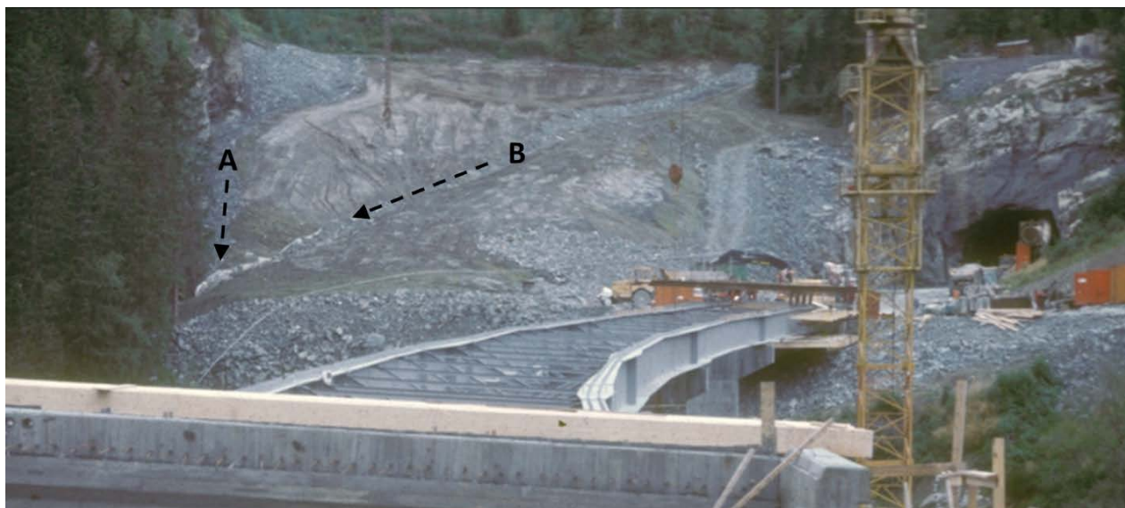
Figur 4-11. Bilde fra bygging av Stavsjøfjelltunnelen, østlig tunneløp, i 1988. Drensgrøfter er vist med svart stiplet linje.
