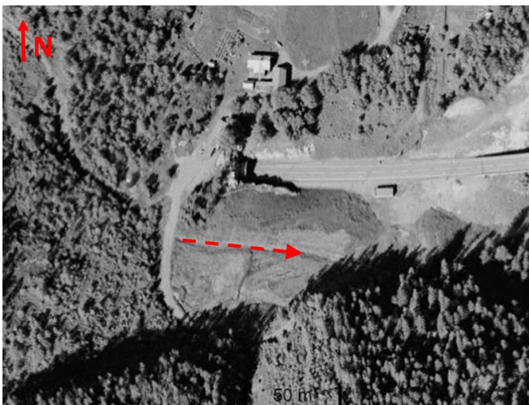
Figur 4-12. Flyfoto over anleggsområdet ved tunnelutløp øst ved Stavsjøfjelltunnelen, 1991. Drenskanalen vises sentralt i bildet (rød stiplet pil), fra anleggsvei ovenfor tunnelutløpet og østover (kart.finn.no).
