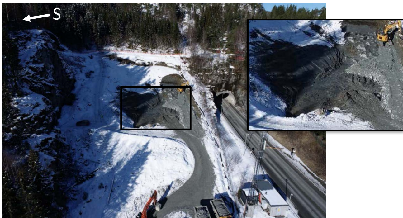
Figur 2-1. Dronebilde av anleggsområdet tatt 7. april 2022, med gravearbeid sentralt i området og drenergrøft i overkant av skråningen (modifisert etter [7]). Drenergrøften ble etablert for å lede vann nordover og inn i rør langs E6. Anleggsveien svinger seg inn mot fjellskrenten og følger denne.
