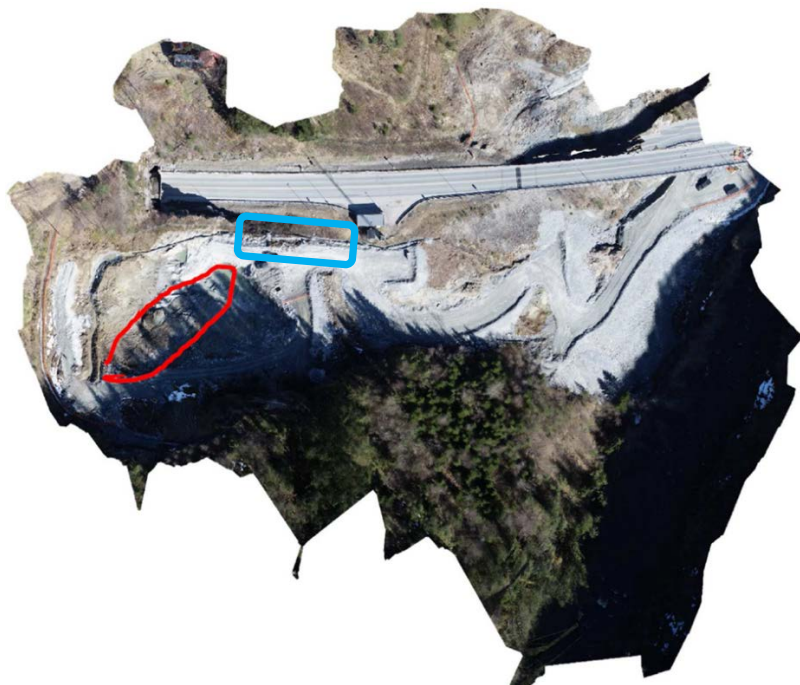
Figur 2-4. Skannet bilde av anleggsområdet etter skredet 20. april 2022. Rød ring viser totalentreprenørens markering av område for skredet 20. april (modifisert etter [7]). Blått rektangel viser området der det ble lagt sprengstein oppå anleggsveien for å etablere en fysisk barriere mot eventuelle nye skred.
