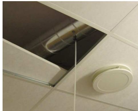
Figur 4 Måling av statisk trykk i kanal.
