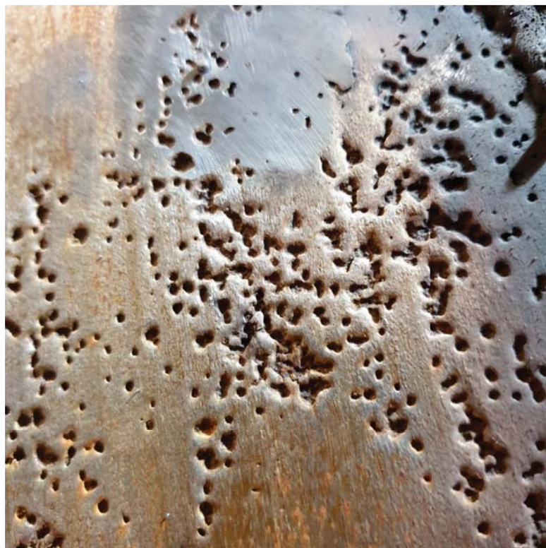
Figur 25. Korrosjonsangrep i Weldox-plater
