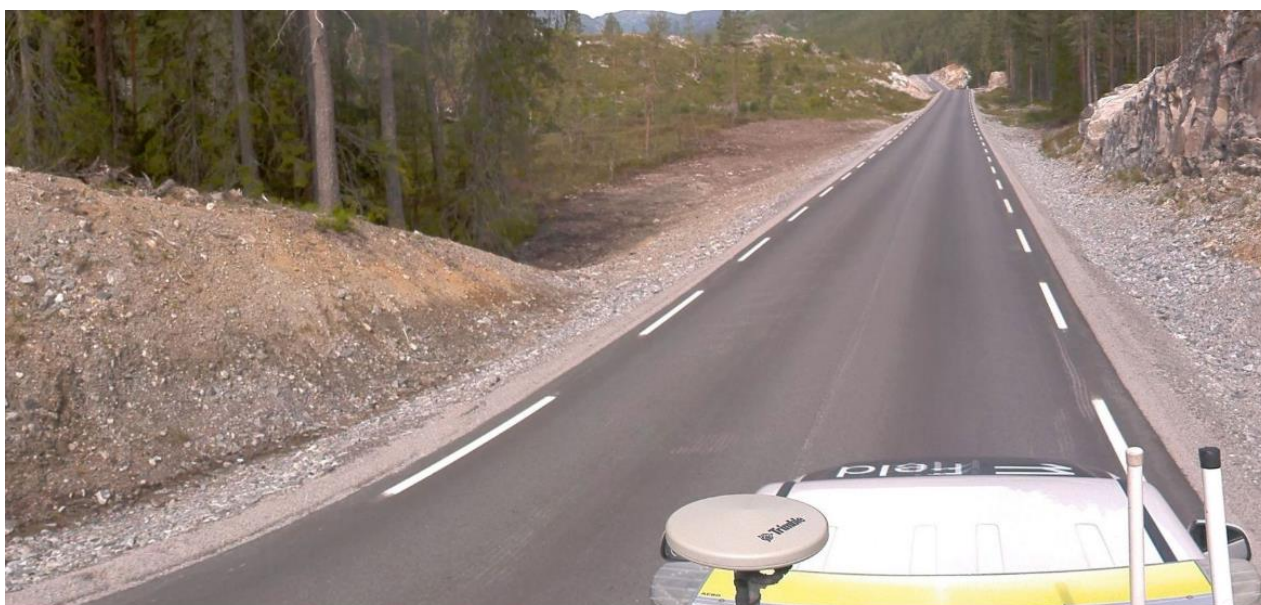
Figur 40 Før tiltak (km 4650)
