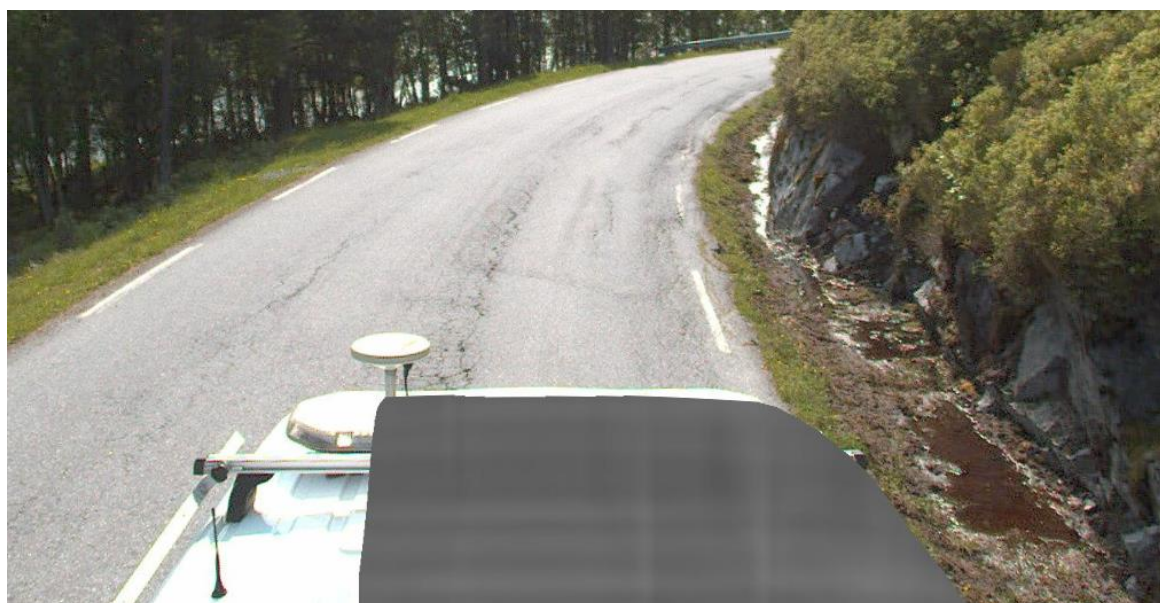
Figur 60 Eksempel på sideterreng som er utfordrende for opparbeidelse av grøft
