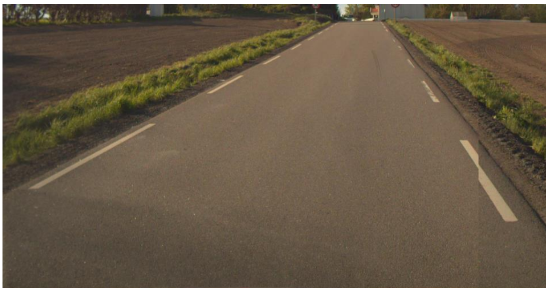
Figur 49 Tilstand før tiltak
